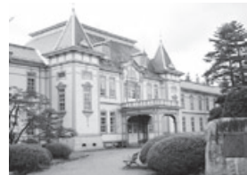
学会の会場となった旧米沢高等工業学校本館
